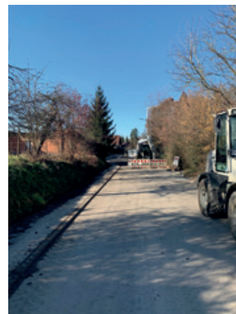
Kanalbau in der Mühlstraße
