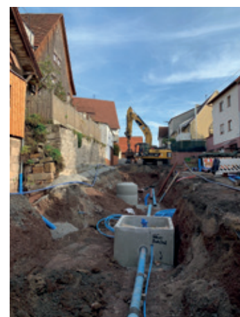
Verlegung der neuen Wasserleitung in der Edelmannstraße
