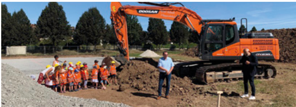
Spatenstich beim Kinderhaus
