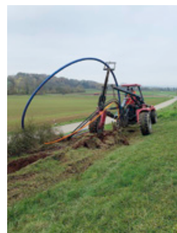
Pflugarbeiten Wasserleitung bei Geddelsbach
