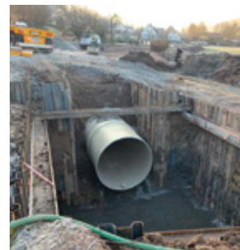
Kanalbau Anschluss Unterheimbach
