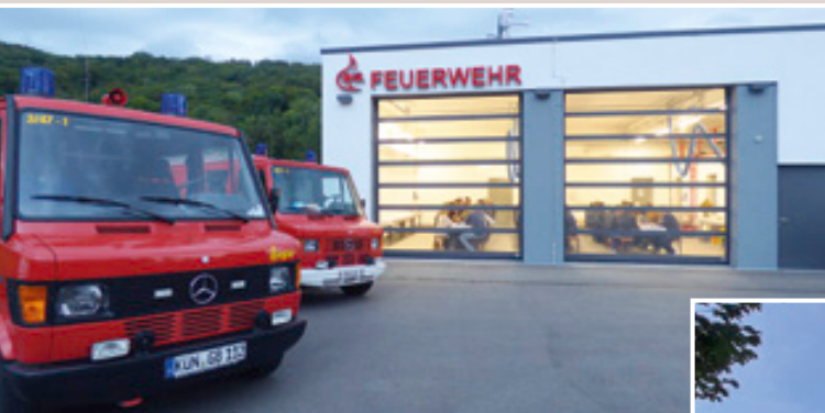
Das neue "Feuerwehrgerätehaus" in Geddelsbach
