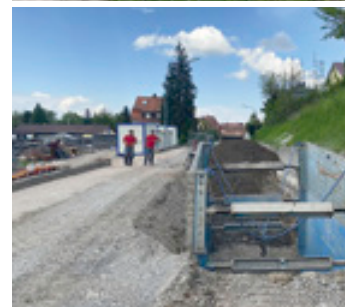
Bilder oben: Sanierung der Adolzfurter Straße in Bretzfeld
